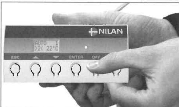
Gå i menuen VIS ALARMER på betjeningspanelet og nulstil alarmen her
